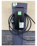
Mit der Umrüstung der E-Ladesäule ist nun auch ein Laden von E-Autos mit einer Leistung bis 11 KW möglich. Für die Nutzung benötigt man die App Monta. Nach der Registrierung und Hinterlegung der Zahlungsmethode ist die Nutzung der Ladesäule möglich.
